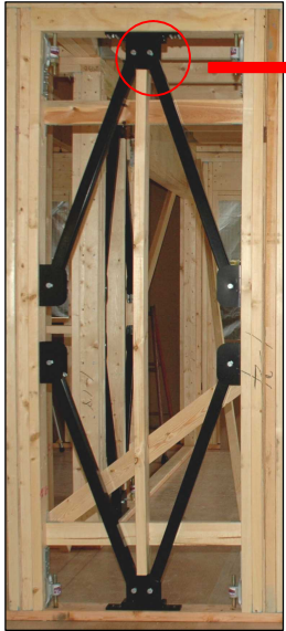
GVA制震フレーム
